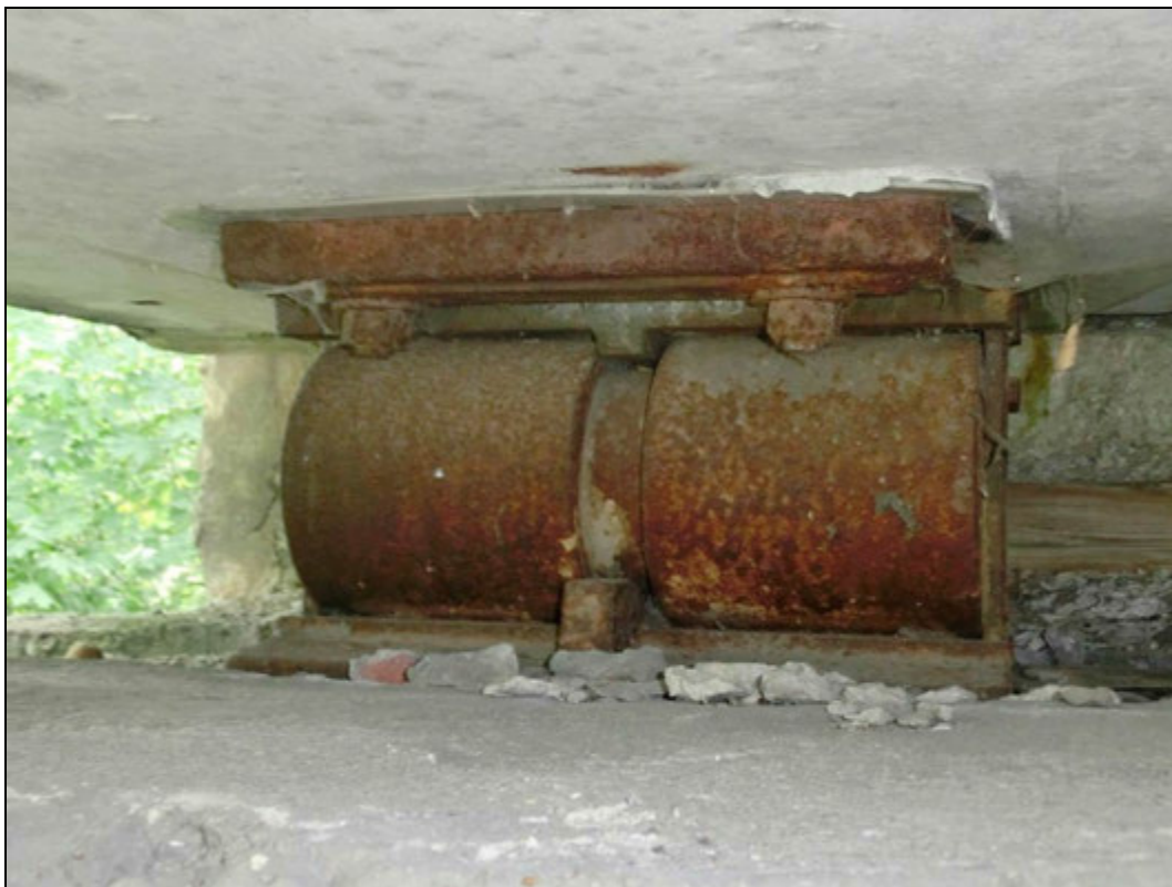
Foto 25: Opěra směr Skuhrov. Korozí poškozená, neošetřená ložiska.
