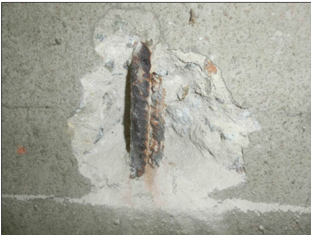
Foto 2: Detail sondy S9, sonda úložný práh opěry, svislá výztuž: žebírková výztuž průměr 14 mm, krytí výztuže cca 10 mm. Na výztuži nalezena silná koroze s tvorbou korozních zplodin a oslabením plochy průřezu 5 – 10 %.
