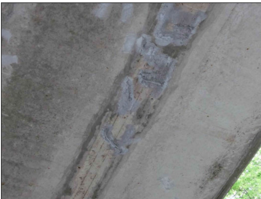
Foto 20: Spodní líc nosné konstrukce, stopy po zatékání. Lokální koroze měkké výztuže nosníků a petlic.
