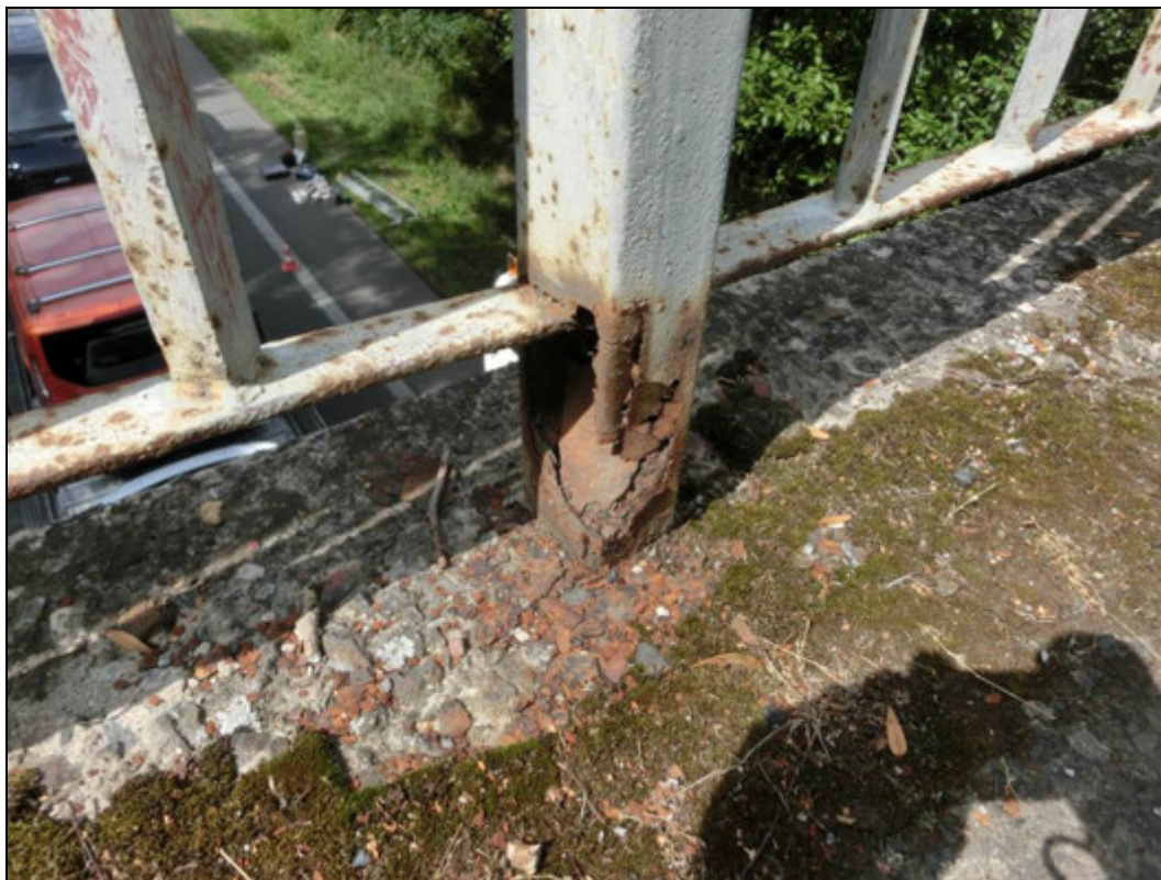
Foto 33: Zcela zkorodovaný sloupek zábradlí.
