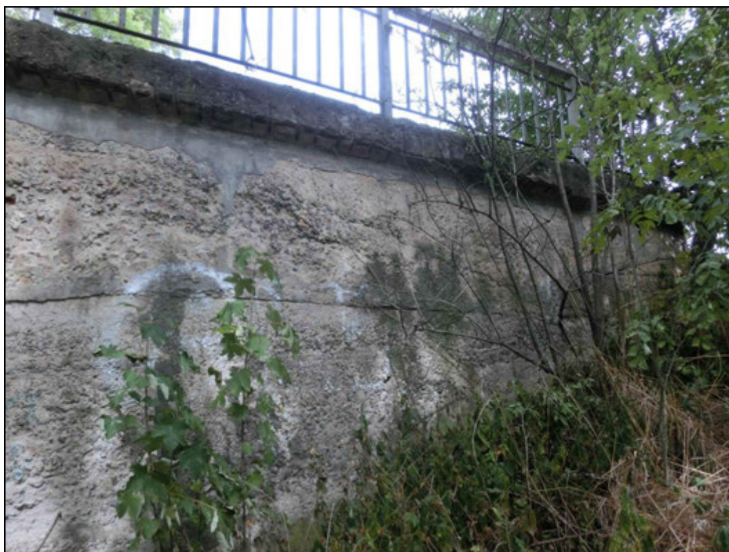
Foto 8: Křídlo u opěry směr Veselá. Stopy po zatékání. Plošná degradace betonu typu V až E.
