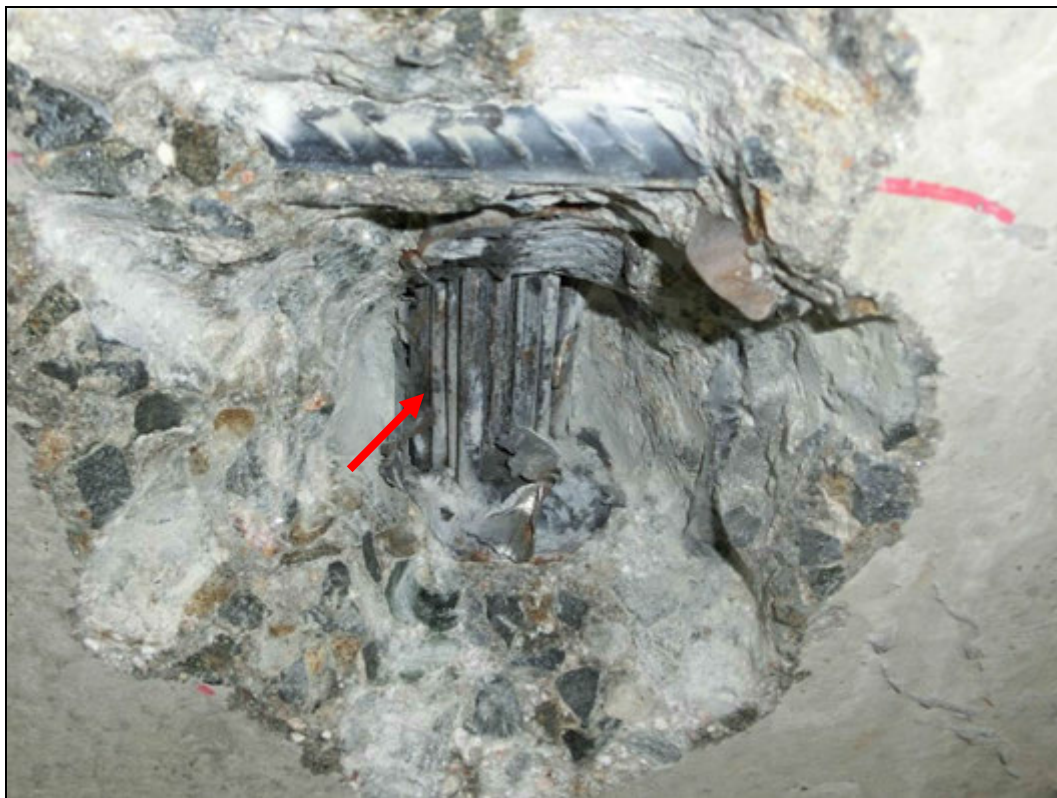
Foto 7: Detail sondy S7, předpínací výztuž nosník I-67, spodní líc. Na předpínací výztuži byla nalezena drobná povrchová koroze. Chránička zcela vyplněna injektážní směsí. Krytí předpínací výztuže cca 55 mm. Poloha viz Příloha 1.
