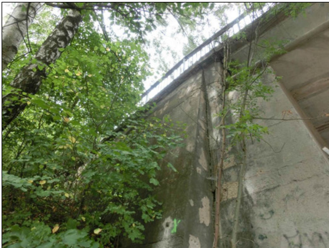
Foto 10: Křídlo u opěry směr Skuhrov. Stopy po zatékání. Plošná degradace betonu typu V.
