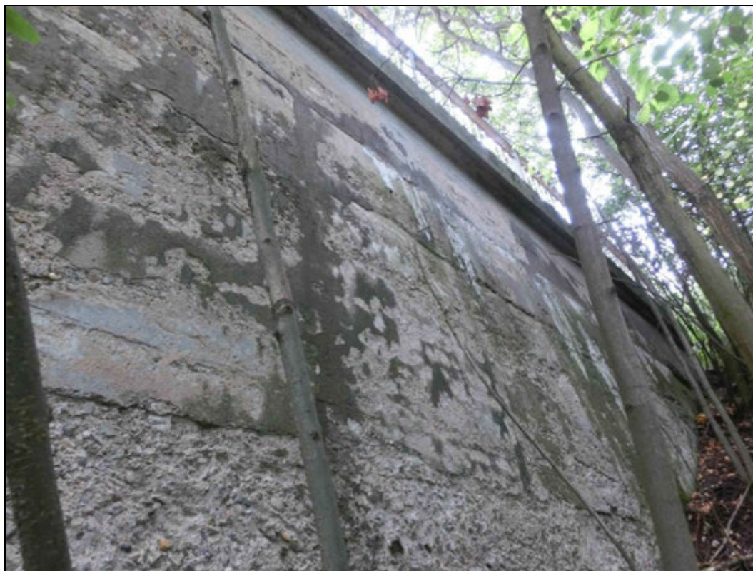
Foto 11: Křídlo u opěry směr Skuhrov. Stopy po zatékání. Plošná degradace betonu typu V až E.
