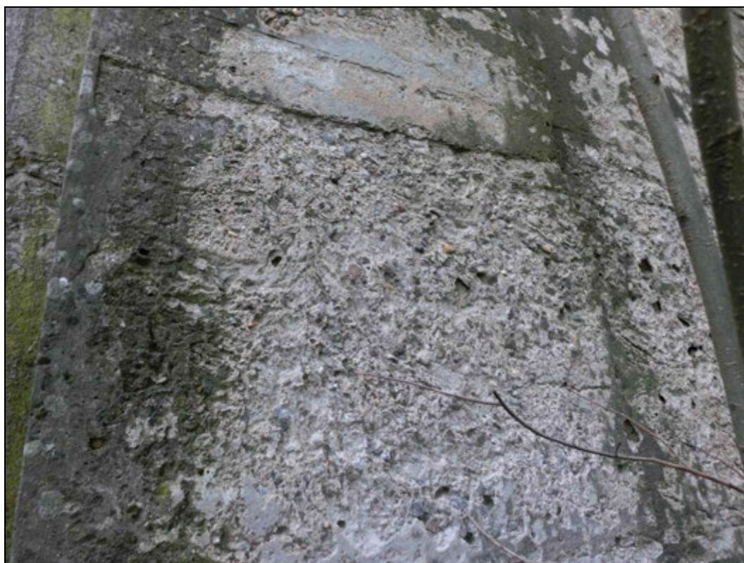
Foto 12: Křídlo u opěry směr Skuhrov. Plošná degradace betonu typu V až E.
