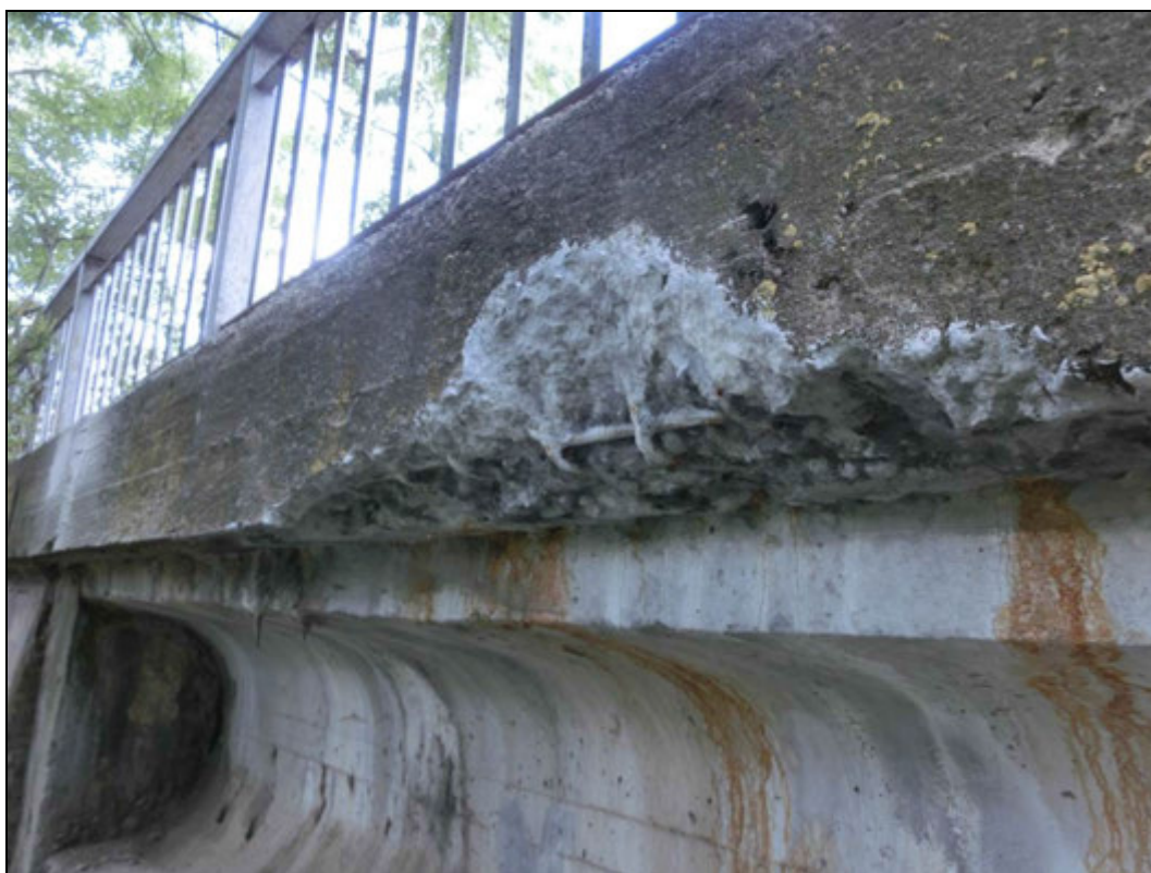
Foto 28: Římsa. Degradovaná spodní hrana římsy. Koroze odhalené výztuže.
