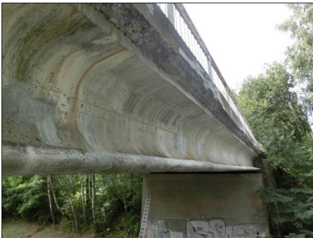
Foto 16: Bok krajního nosníku. Stopy po zatékání. Lokální koroze měkké výztuže nosníků.
