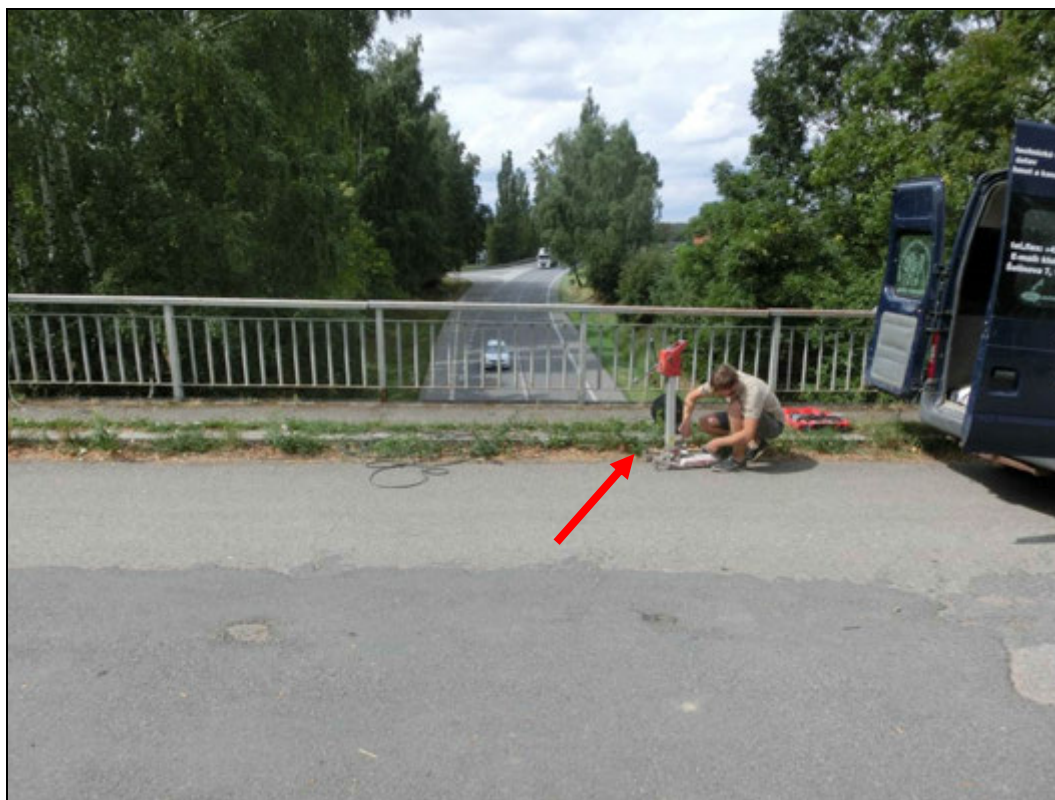
Foto 3: Pohled do provádění jádrového vrtu V11, pro stanovení skladby vozovky.
