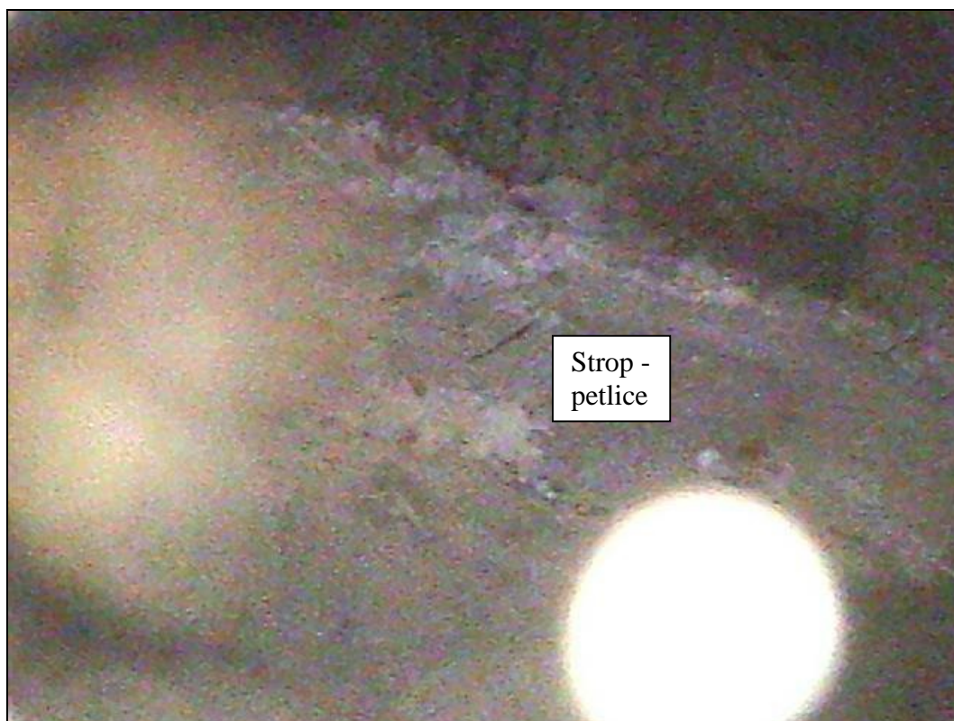
Foto 2: Detail vnitřního povrchu prostoru mezi nosníky I-67. Sonda 2, Poloha viz Příloha 1. Masivní zatékání do prostoru mezi nosníky, krápníky a výluhy. Koroze měkké výztuže nosníků a petlice.
