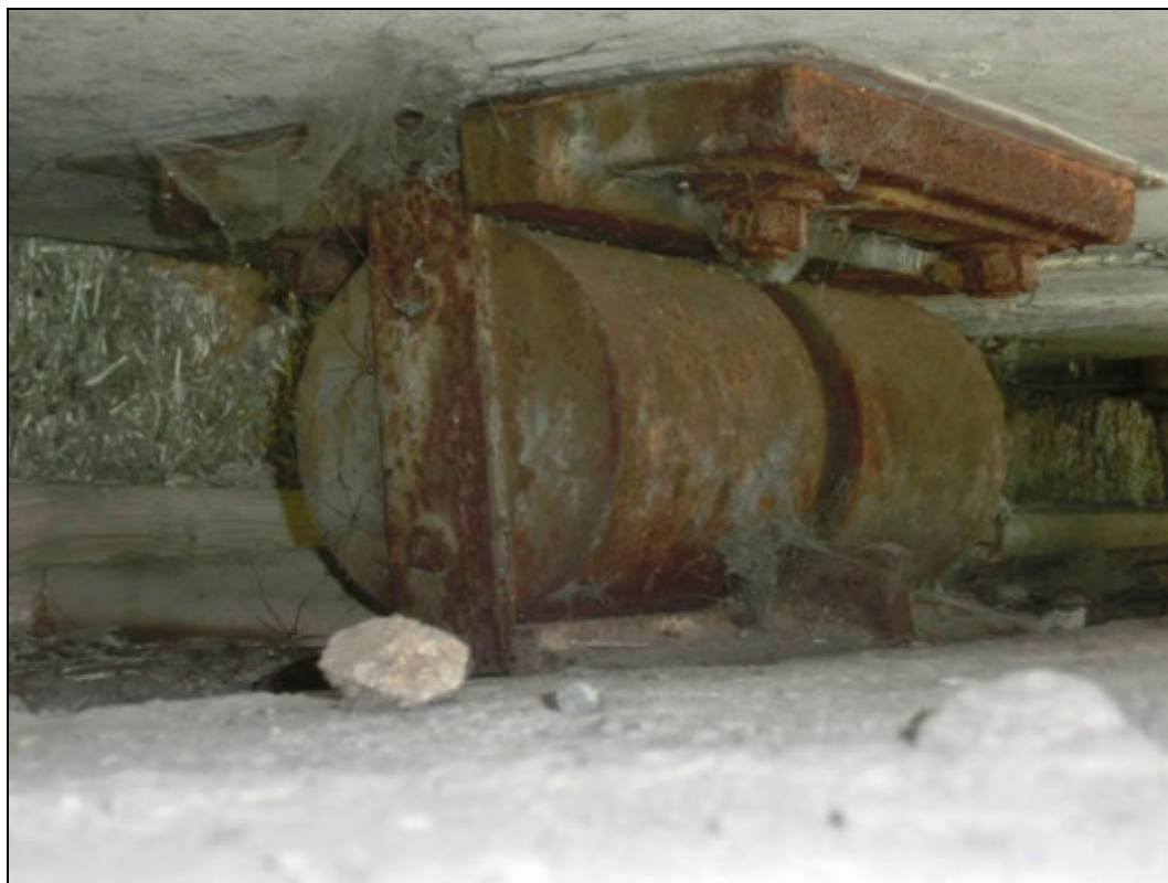
Foto 26: Opěra směr Skuhrov. Korozí poškozená, neošetřená ložiska.
