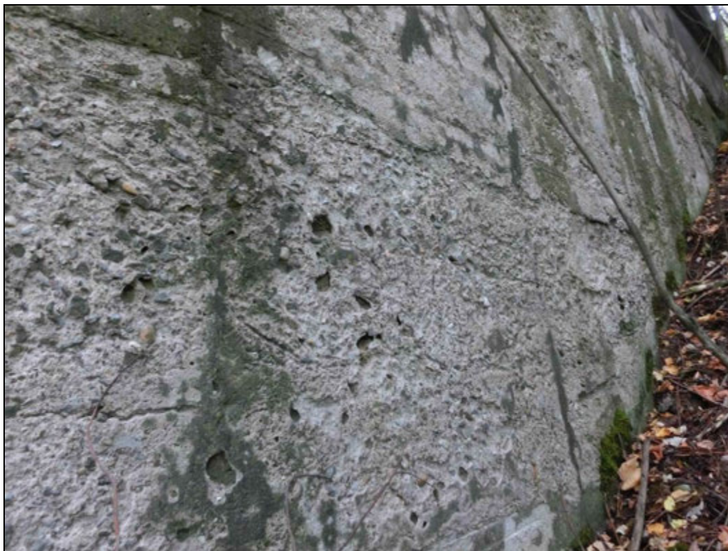
Foto 13: Křídlo u opěry směr Skuhrov. Plošná degradace betonu typu V až E.
