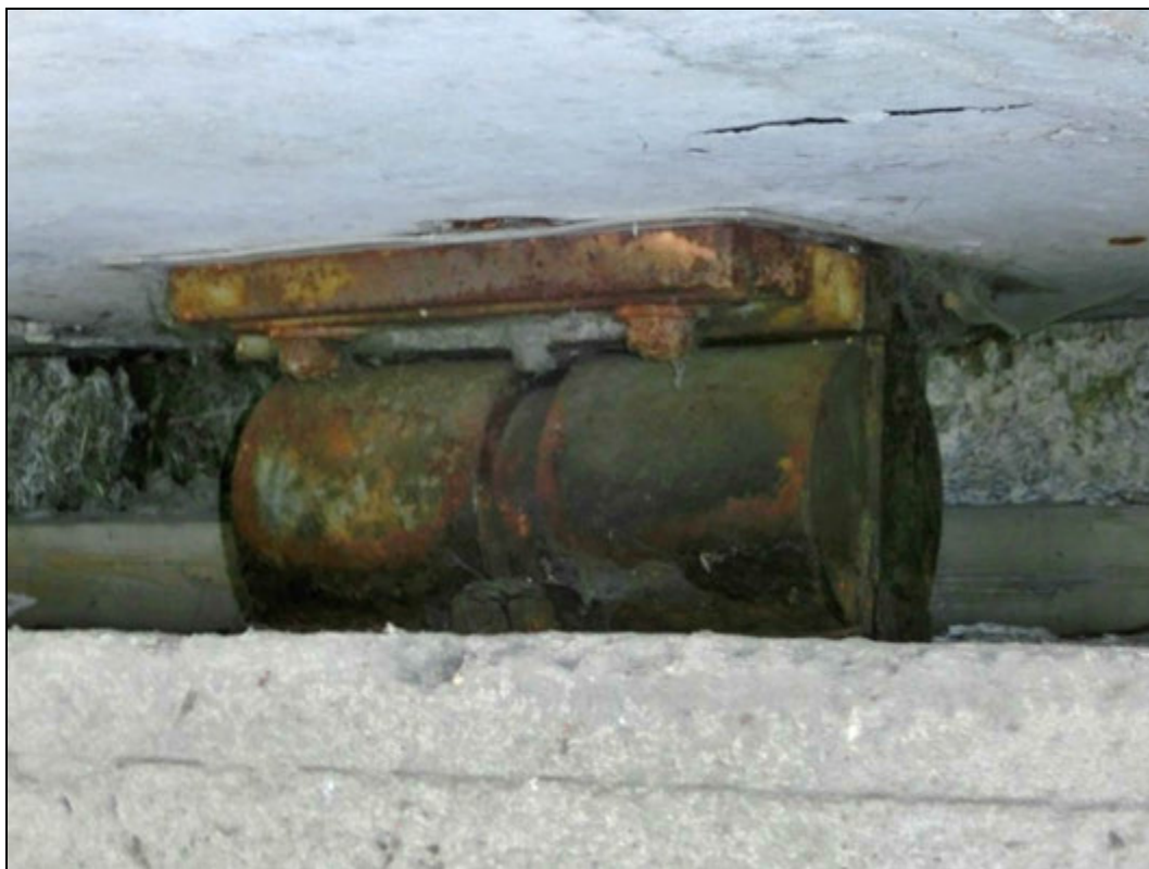
Foto 24: Opěra směr Skuhrov. Korozí poškozená, neošetřená ložiska.
