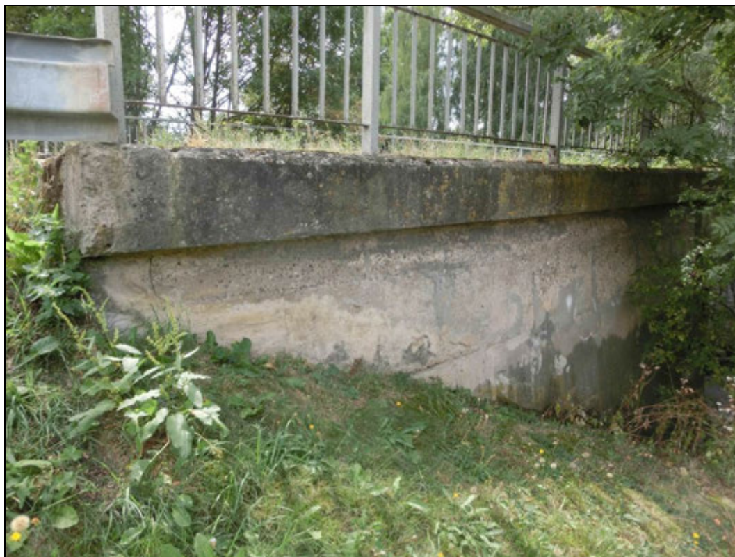
Foto 7: Křídlo u opěry směr Veselá. Stopy po zatékání. Plošná degradace betonu typu V až E.
