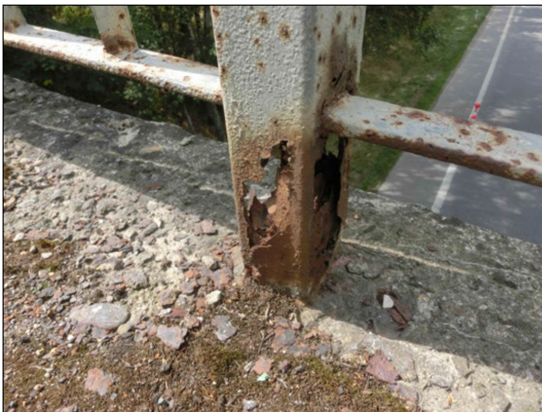
Foto 32: Zcela zkorodovaný sloupek zábradlí.
