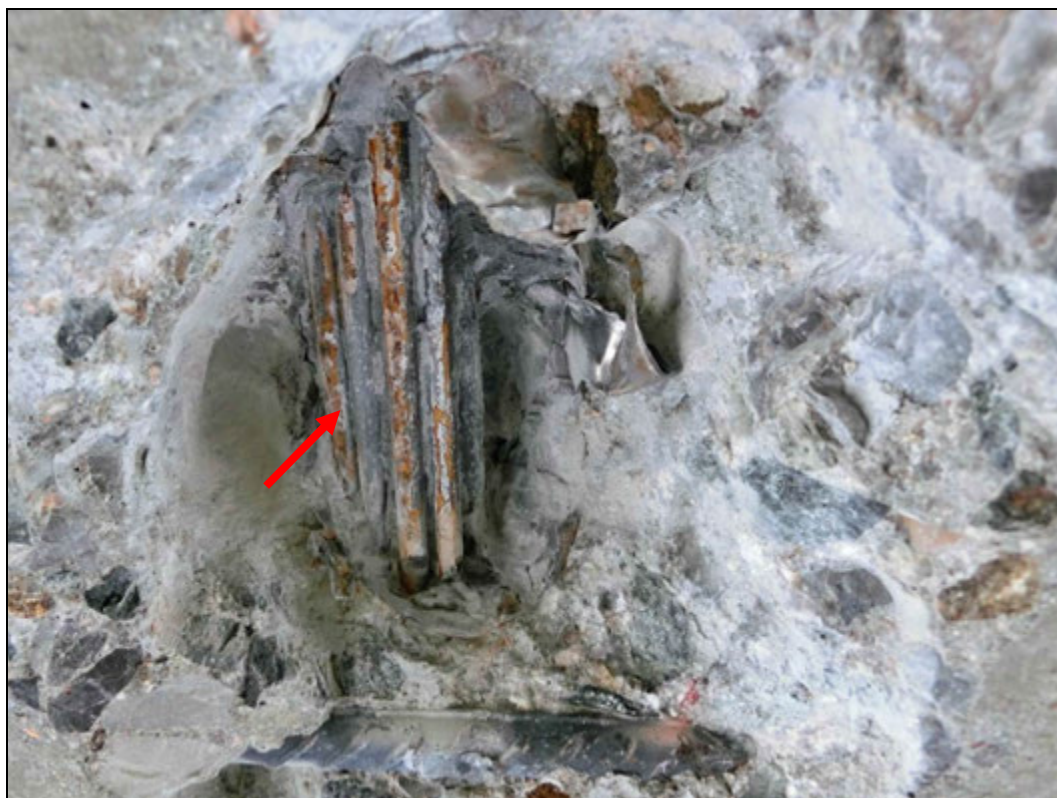
Foto 2: Detail sondy S2, předpínací výztuž nosník I-67, spodní líc. Na předpínací výztuži byla nalezena povrchová koroze. Chránička zcela vyplněna injektážní směsí. Krytí předpínací výztuže cca 50 mm. Poloha viz Příloha 1.
