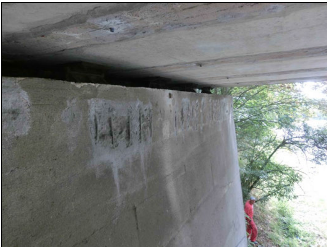
Foto 6: Opěra směr Veselá. Stopy po zatékání Koroze výztuže úložného prahu.
