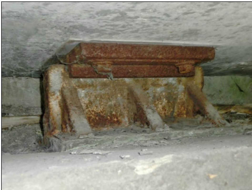
Foto 23: Opěra směr Veselá. Korozí poškozená, neošetřená ložiska.
