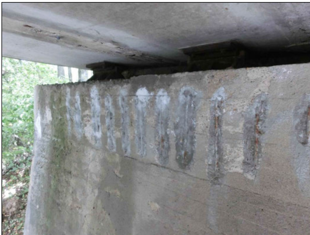
Foto 5: Opěra směr Veselá. Stopy po zatékání Koroze výztuže úložného prahu.
