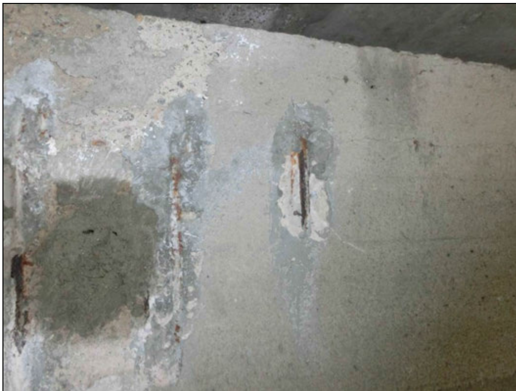
Foto 1: Detail sondy S8, sonda úložný práh opěry, svislá výztuž: žebírková výztuž průměr 14 mm, krytí výztuže cca 10 mm. Na výztuži nalezena silná koroze s tvorbou korozních zplodin a oslabením plochy průřezu 5 – 10 %.
