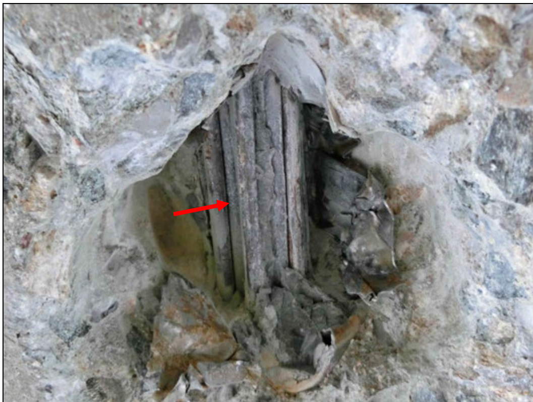
Foto 3: Detail sondy S3, předpínací výztuž nosník I-67, spodní líc. Na předpínací výztuži nebyla nalezena korozе. Chránička zcela vyplněna injektážní směsí. Krytí předpínací výztuže cca 50 mm. Poloha viz Příloha 1.
