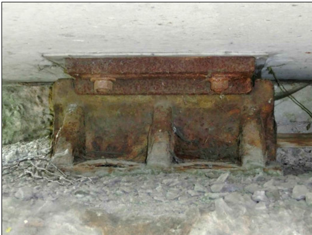
Foto 21: Opěra směr Veselá. Korozí poškozená, neošetřená ložiska.
