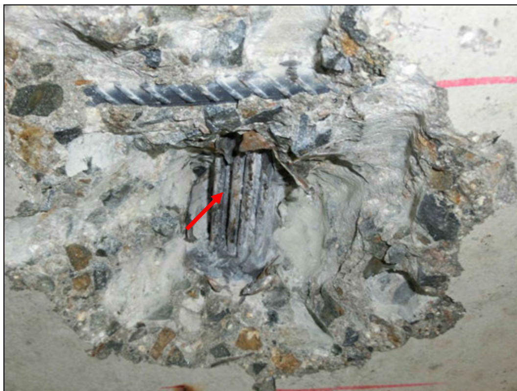
Foto 6: Detail sondy S8, předpínací výztuž nosník I-67, spodní líc. Na předpínací výztuži byla nalezena drobná povrchová korozе. Chránička zcela vyplněna injektážní směsí. Krytí předpínací výztuže cca 50 mm. Poloha viz Příloha 1.
