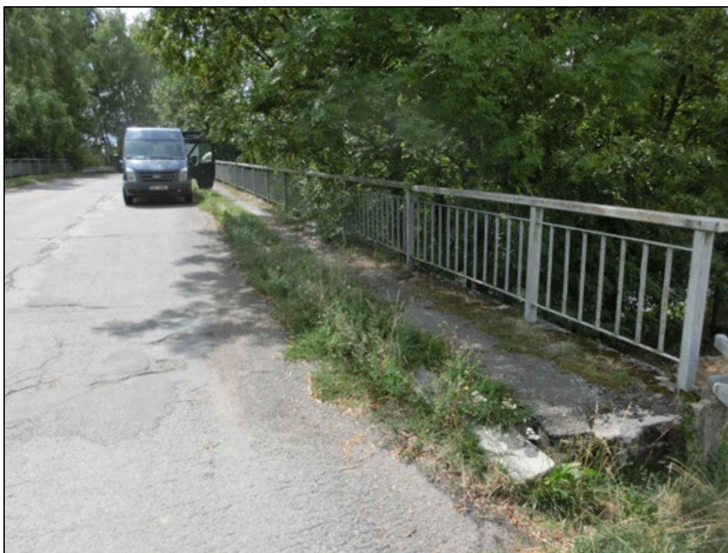
Foto 30: Pohled na vozovku a chodníky. Nerovnosti, trhliny a výtluky ve vozovce. V chodnících uchycena vegetace.
