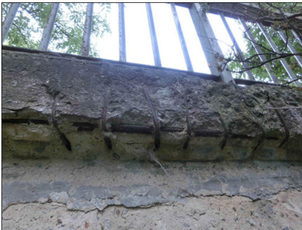
Foto 27: Římsa. Degradovaná spodní hrana římsy. Koroze odhalené výztuže.
