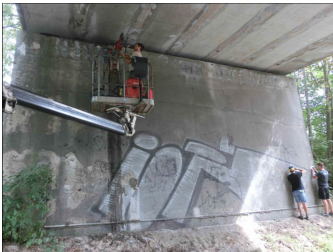
Foto 4: Opěra směr Veselá. Koroze výztuže úložného prahu. Na krajích opěry stopy po zatékání.
