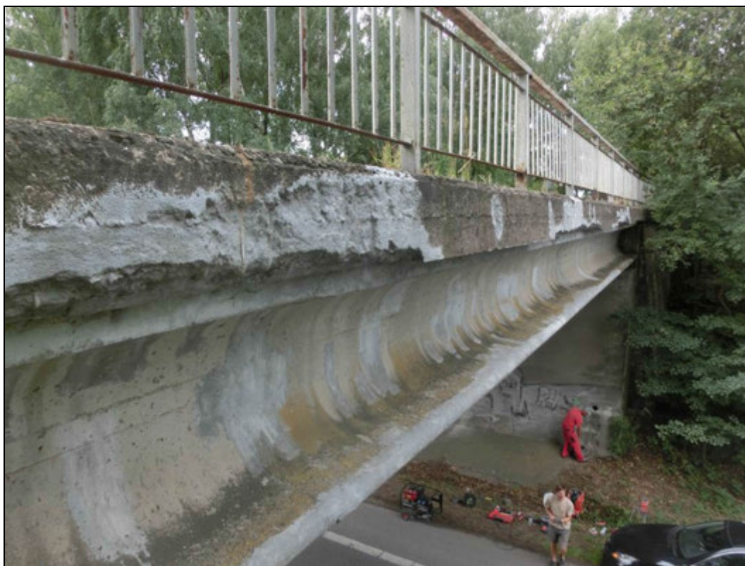
Foto 15: Bok krajního nosníku. Stopy po zatékání. Lokální koroze měkké výztuže nosníků.
