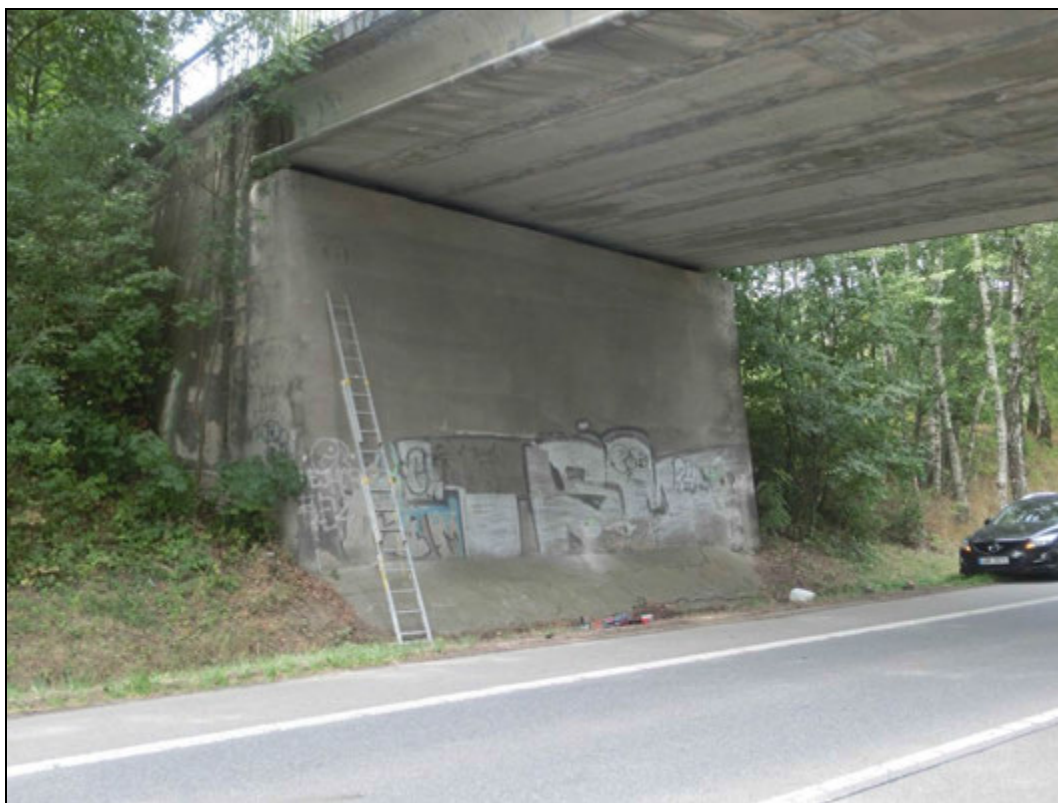
Foto 3: Opěra směr Skuhrov. Na krajích opěry stopy po zatékání.
