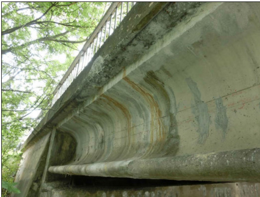
Foto 17: Bok krajního nosníku. Stopy po zatékání. Lokální koroze měkké výztuže nosníků.
