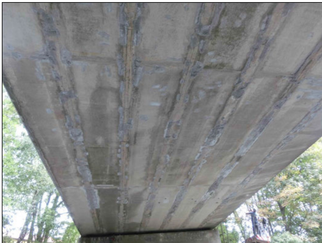
Foto 14: Spodní líc nosné konstrukce, stopy po zatékání. Lokální koroze měkké výztuže nosníků.
