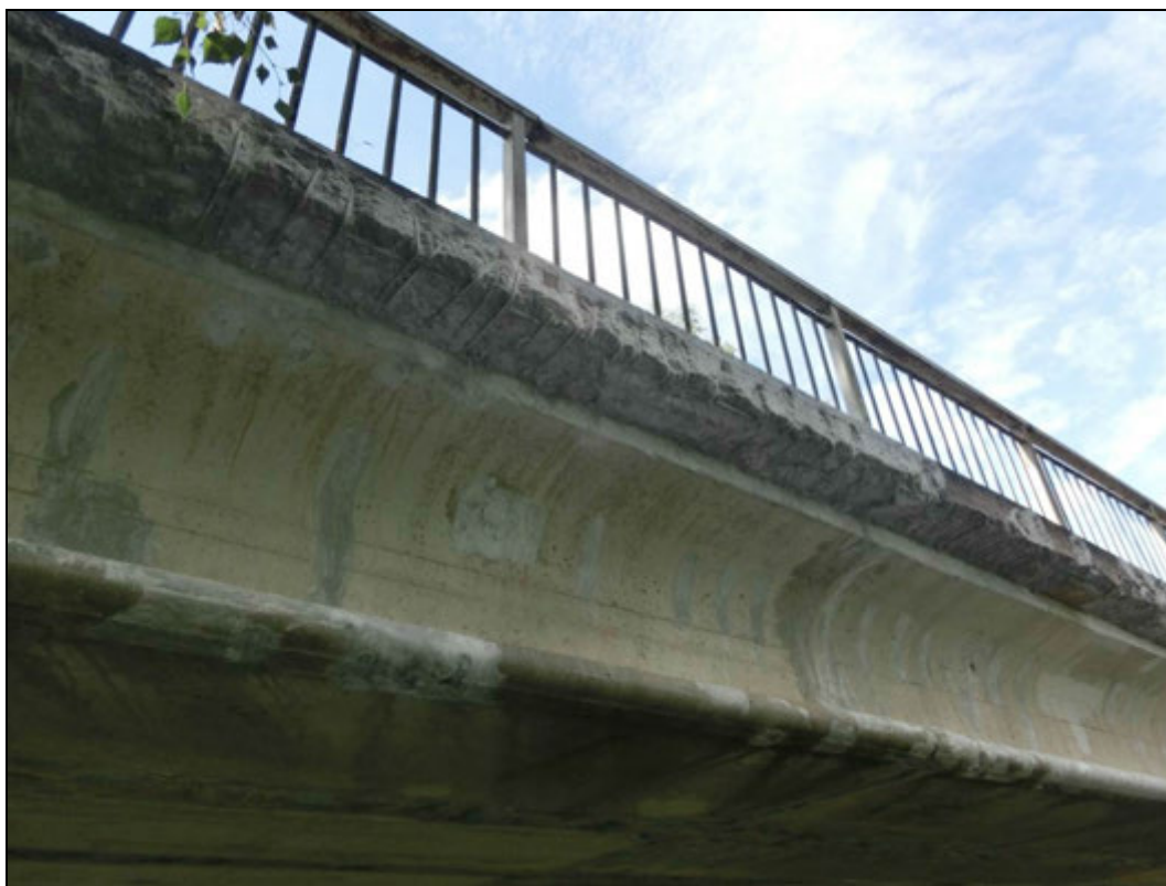
Foto 18: Bok krajního nosníku. Stopy po zatékání. Lokální koroze měkké výztuže nosníků.
