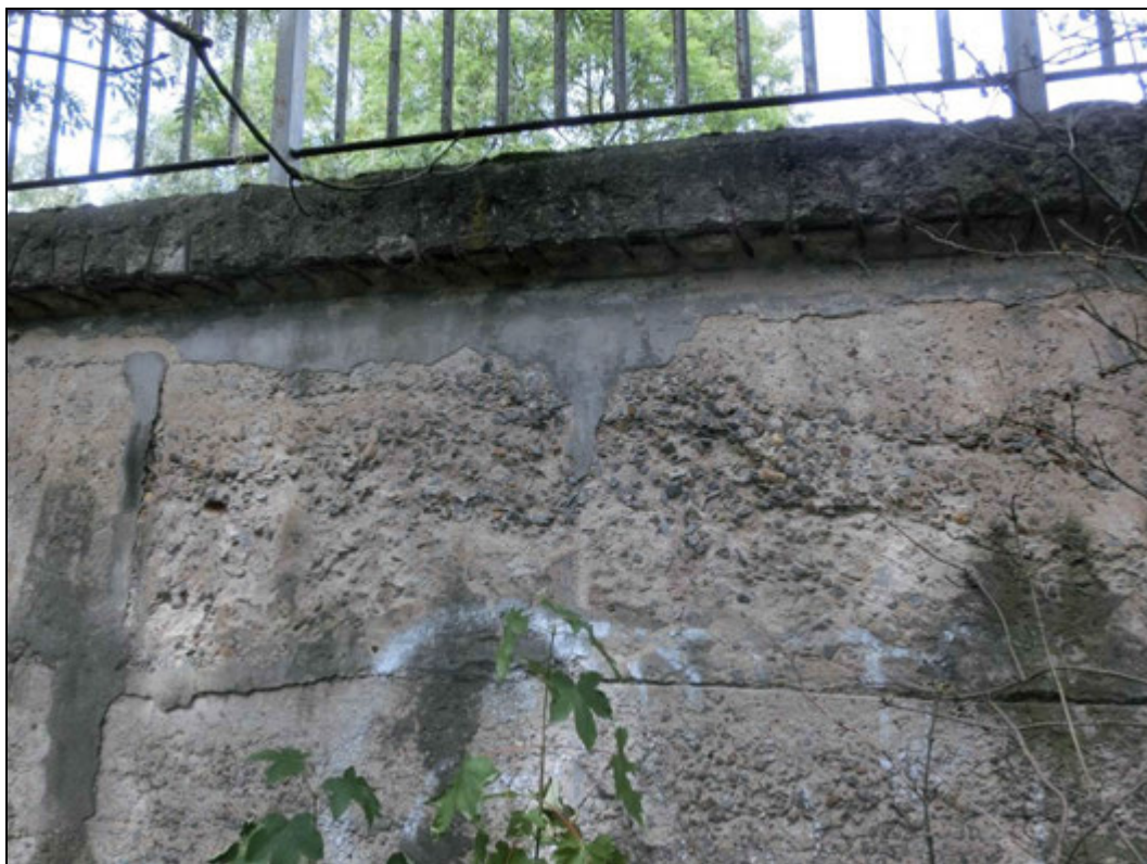
Foto 9: Křídlo u opěry směr Veselá. Stopy po zatékání. Plošná degradace betonu typu V až E.
