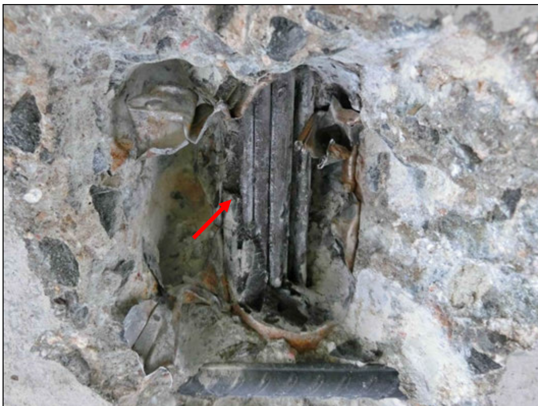
Foto 4: Detail sondy S4, předpínací výztuž nosník I-67, spodní líc. Na předpínací výztuži nebyla nalezena korozе. Chránička zcela vyplněna injektážní směsí. Krytí předpínací výztuže cca 55 mm. Poloha viz Příloha 1.
