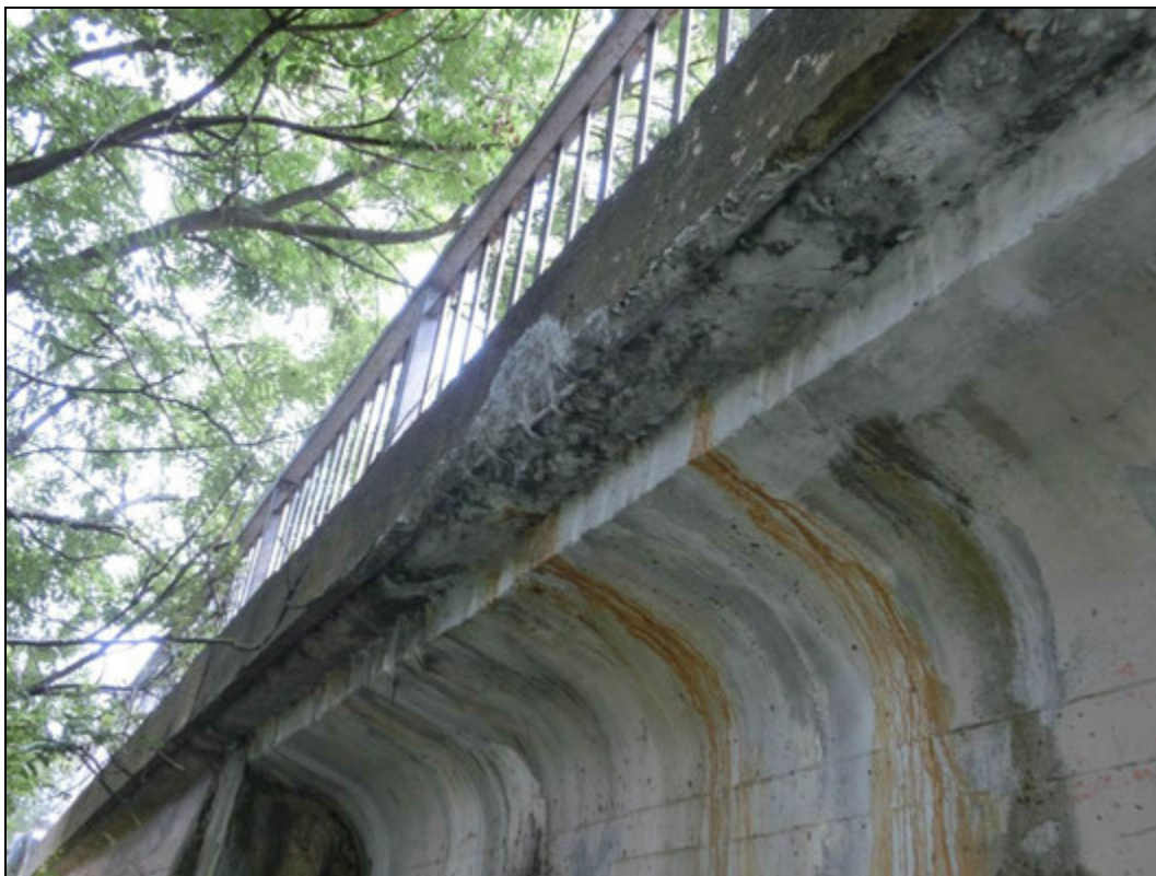
Foto 19: Bok krajního nosníku. Stopy po zatékání. Lokální koroze měkké výztuže nosníků.
