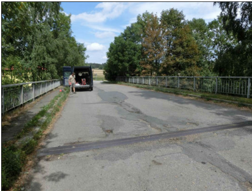
Foto 29: Pohled na vozovku a chodníky. Nerovnosti, trhliny a výtluky ve vozovce. V chodnících uchycena vegetace.
