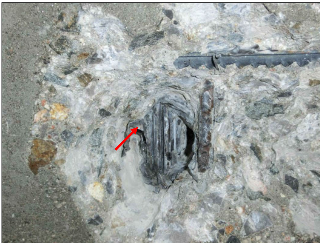
Foto 5: Detail sondy S5, předpínací výztuž nosník I-67, spodní líc. Na předpínací výztuži nebyla nalezena korozе. Chránička zcela vyplněna injektážní směsí. Krytí předpínací výztuže cca 60 mm. Poloha viz Příloha 1.
