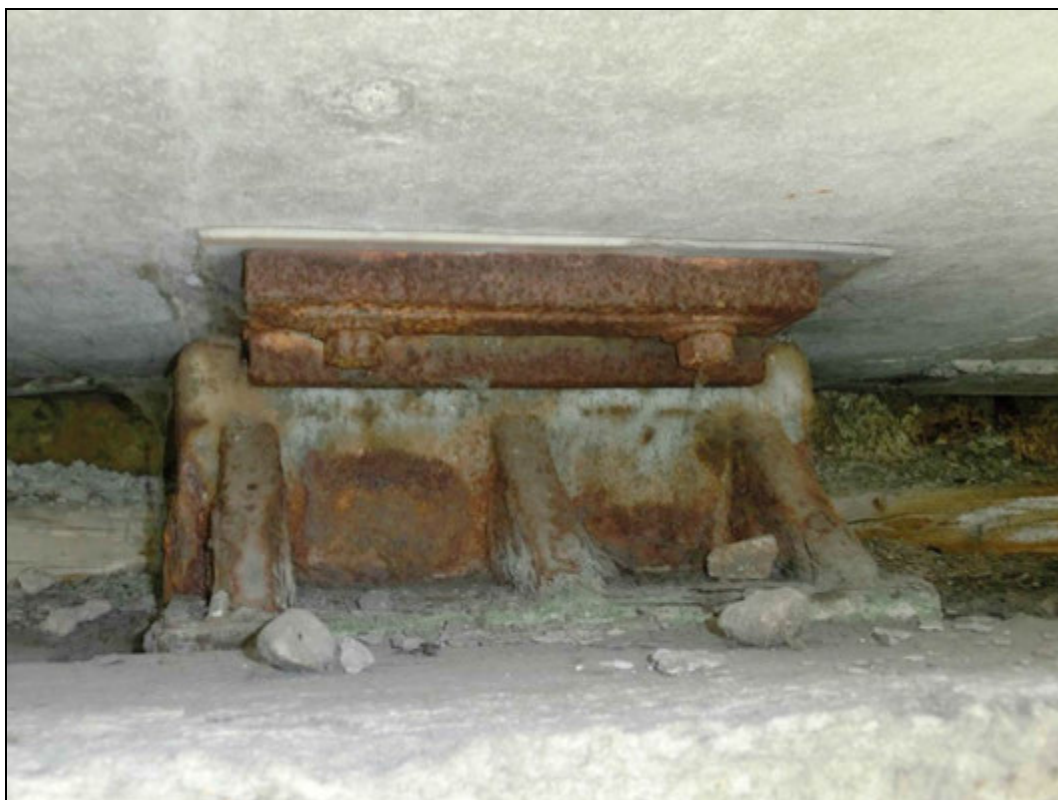
Foto 22: Opěra směr Veselá. Korozí poškozená, neošetřená ložiska.
